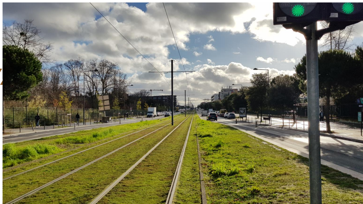
Alignement arboré autour de la plateforme du T7 (station Domaine Chérioux)
