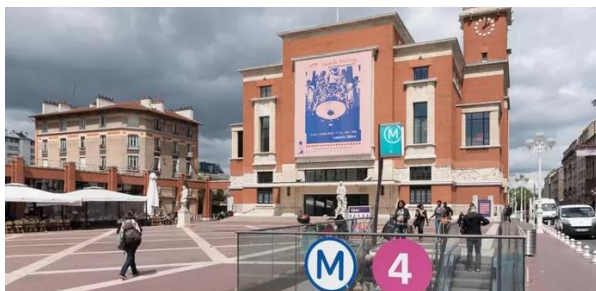
Exemple d'émergence – Mairie de Montrouge M4
