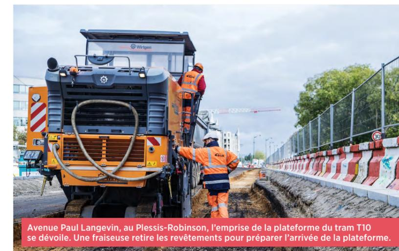
Avenue Paul Langevin, au Plessis-Robinson, l'emprise de la plateforme du tram T10 se dévoile. Une fraiseuse retire les revêtements pour préparer l'arrivée de la plateforme.
