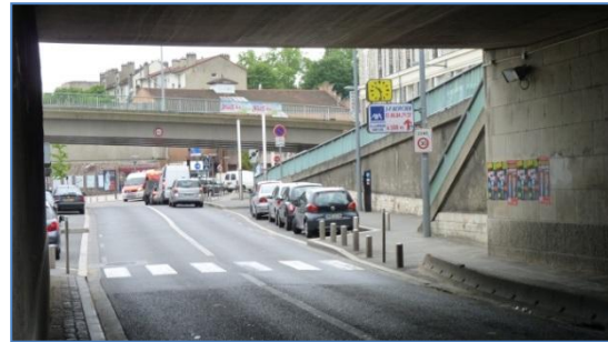
Illustration 105. Passage sous la RD86 : cheminement piéton très étroit
