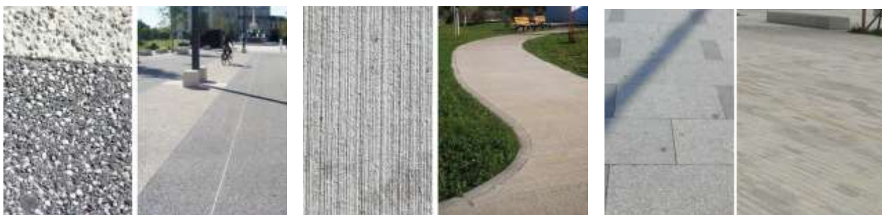
a : enrobé noir grenailé / b : béton balayé beige c : dallage de pierre naturelle
