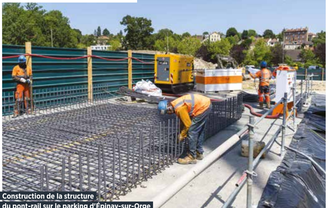
Les équipes SNCF et Île-de-France Mobilités mobilisées pour la construction du tram T12
