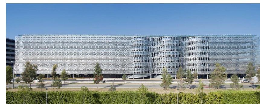
Figure 36 : Exemple du parking de l'Aéroport Toulouse Blagnac
