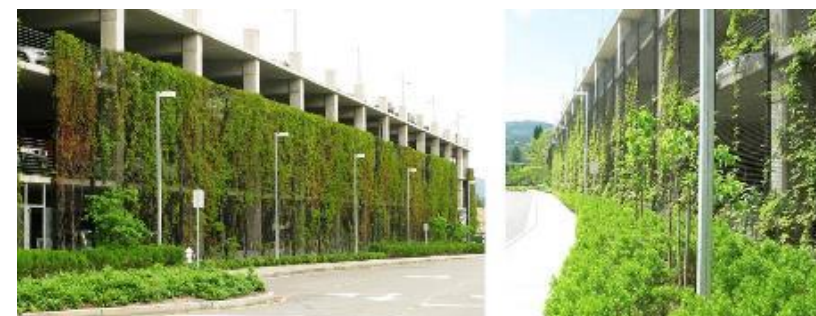
Figure 35 : Exemple du parking ISSAQUAH Transit Center
