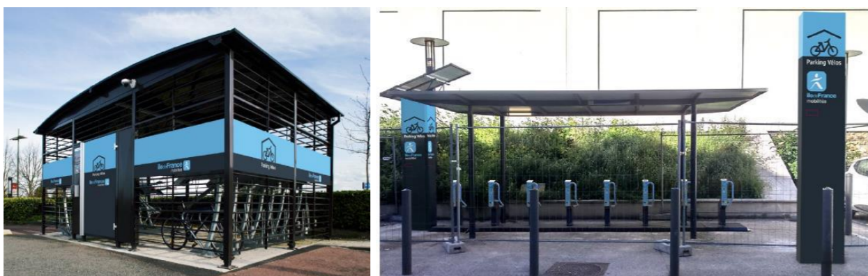
Figure 293 - Exemples de stationnements vélos – services « Parking Vélos » - consignes sécurisés (gauche) et arceaux vélos abrités (droite)
