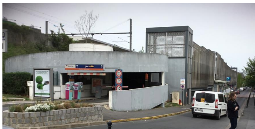
Figure 53 - Parc-relais de Chelles (Source : Egis, 2019)
