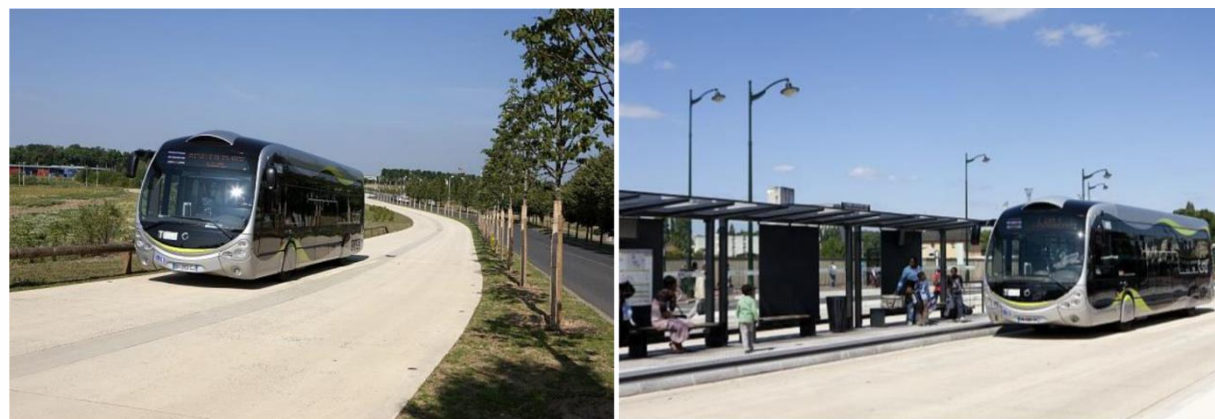
Figure 48 : Plateforme et station du T Zen 1 Source : Cahier de références des aménagements T Zen, STIF, Avril 2013
