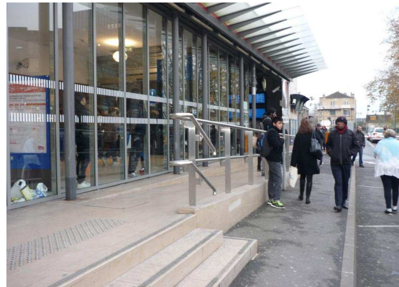
Figure 47 : Rampe d'accès au bâtiment voyageurs
