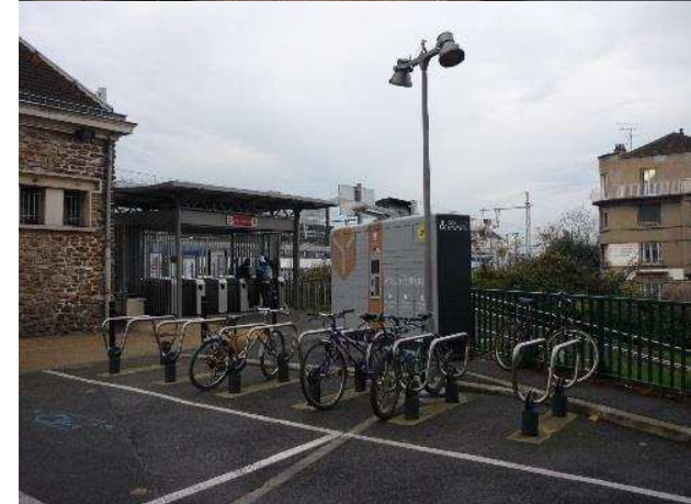
Figure 58 : Arceaux pour le stationnement des vélos place Gallieni
