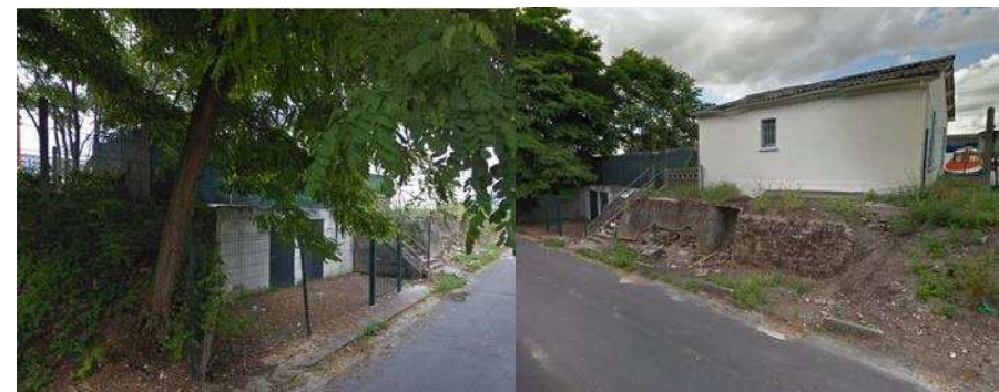
Locaux techniques Talus
