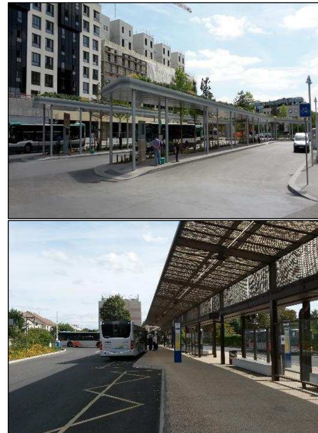
Figure 82 : Exemples récents de gares routières paysagées en Ile-de-France : à gauche : Rueil Malmaison (92), à droite Herblay (95)
