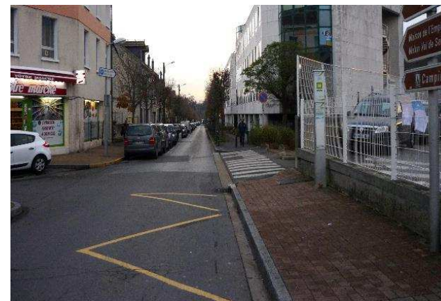
Quai trottoir de la ligne M av. de la Libération
