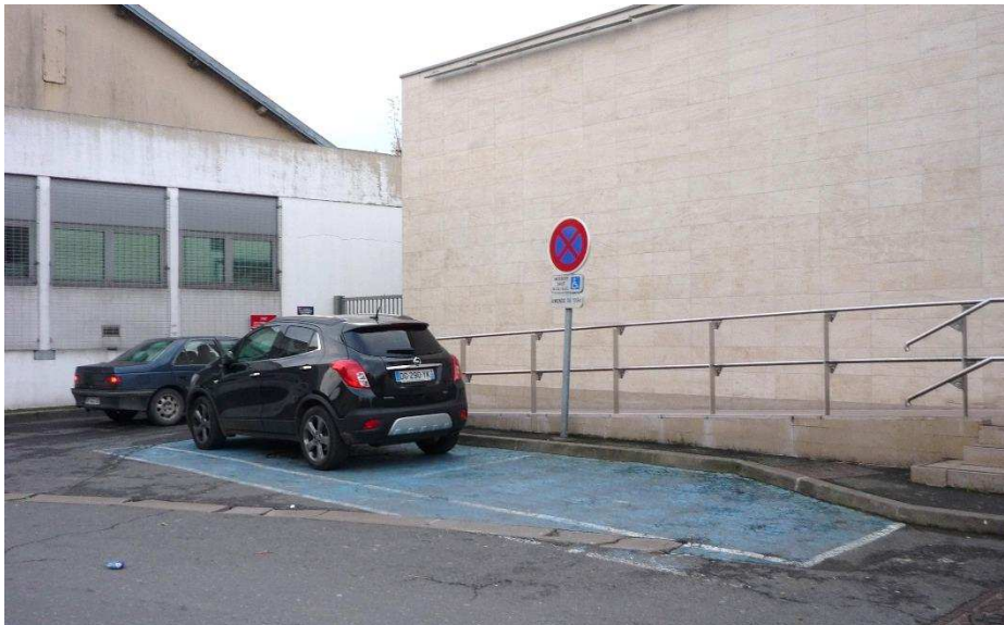
Figure 67 : Places de stationnement PMR devant le bâtiment voyageurs de la gare
