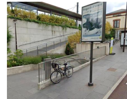
Figure 93 : Emergence de la station Viroflay-Rive Droite du T6
