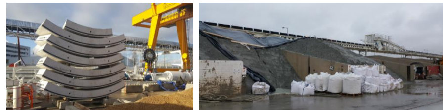
Figure 94 : Exemple d'installations de chantier pour l'ouvrage de démarrage
