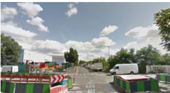
Photo de l'existant (Google Street View)
