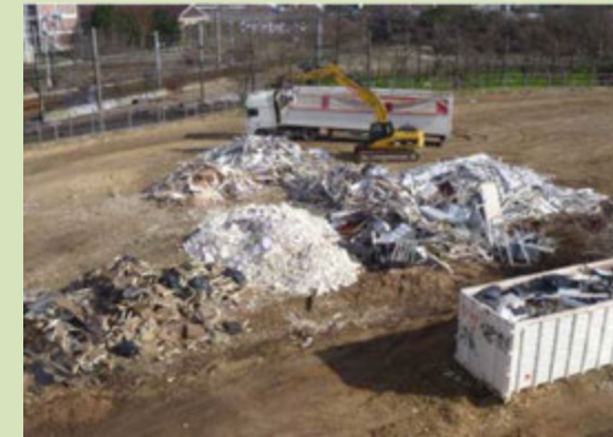
Figure 229 : Tri des déchets sur le chantier
