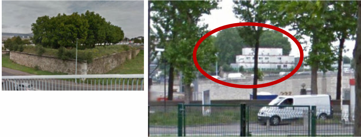
Figure 242 : photo de gauche (vue directe du monument historique) / photo de droite (vue depuis le tracé le quai Marcel Boyer)
