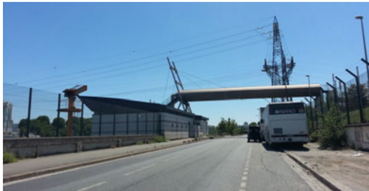
Figure 235 : Lignes à haute tension localisées au-dessus du quai Jules Guesde aux Ardoines Source : SNC-Lavalin, Juin 2014
