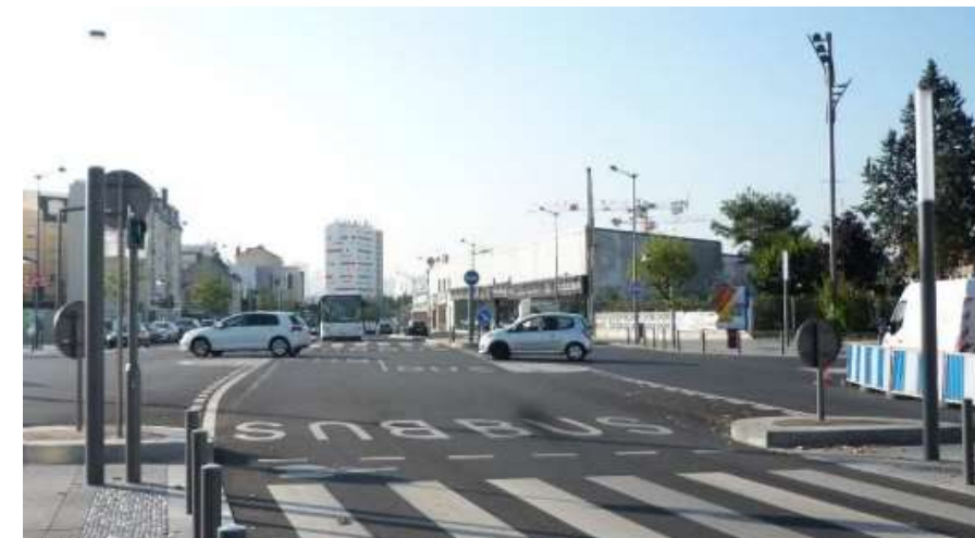
Figure 121 : Site propre existant sur RD392 entre le Pont de Bezons et la rue Edouard Vaillant
