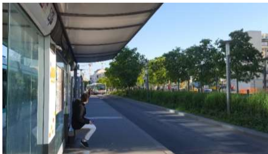
Figure 137 : Quais ouest (à gauche) et est (à droite) au droit de la plateforme du tramway T2
