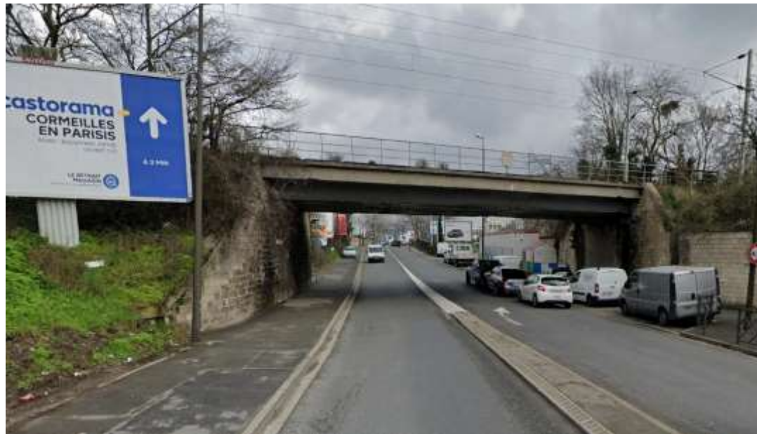
Figure 132 : Profil actuel de l'ouvrage SNCF situé sur la RD392
