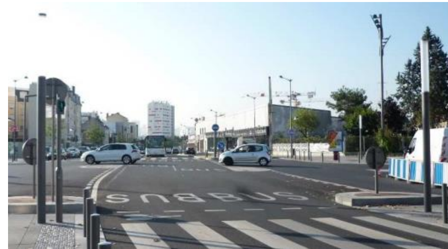
Figure 70 : Site propre existant sur RD392 entre le Pont de Bezons et la rue Edouard Vaillant
