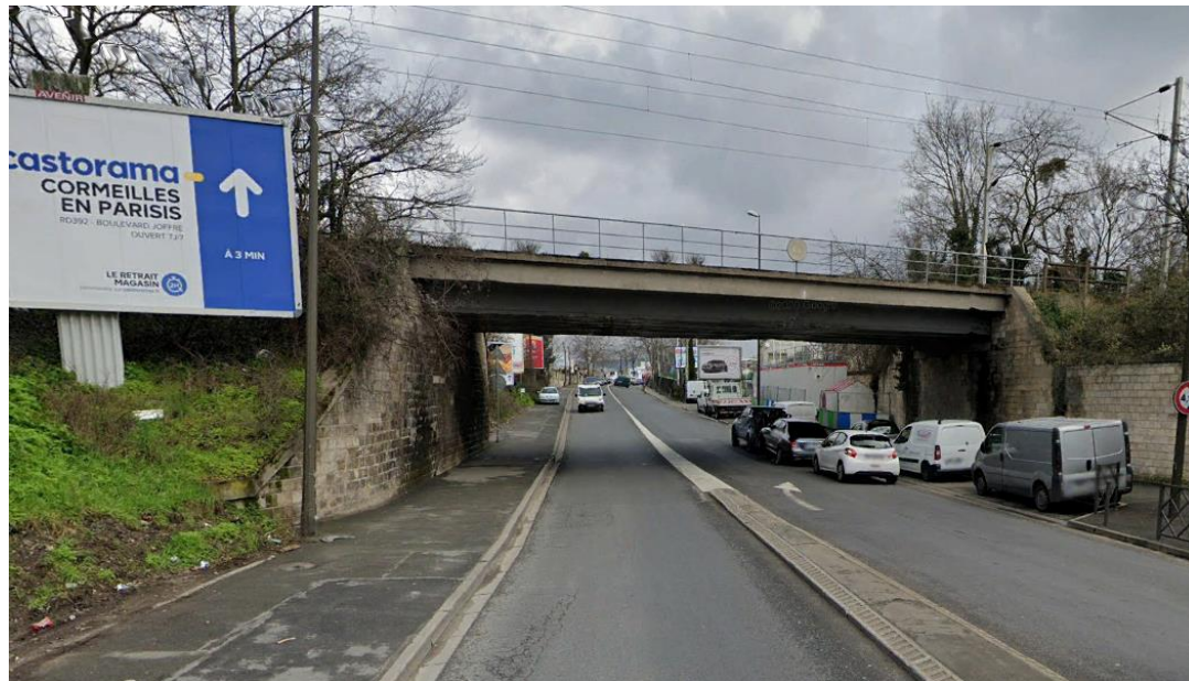
Figure 81 : Profil actuel de l'ouvrage SNCF situé sur la RD392
