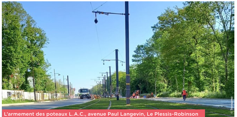
L'armement des poteaux L.A.C., avenue Paul Langevin, Le Plessis-Robinson
