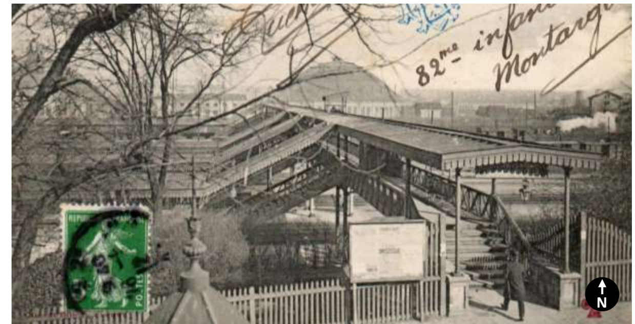
24. Passerelle d'accès aux quais historique (Source : https://www.cparama.com/forum/noisy-le-sec-t1484.html )
