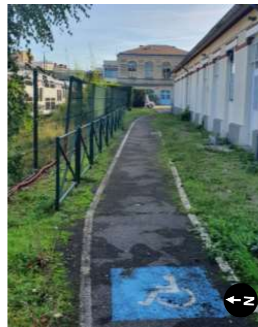
50. Accès PMR depuis le niveau bas de la gare (Source : Artelia-Richez, 2022)
