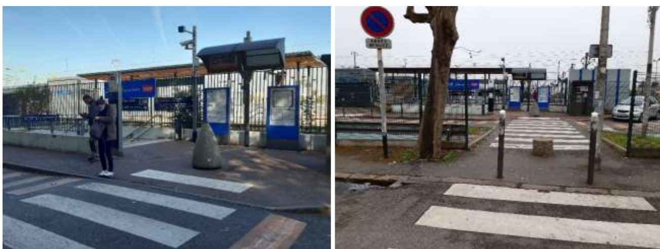
92. Vue accès quai et PASO bas (Artelia-Richez, 2022)
