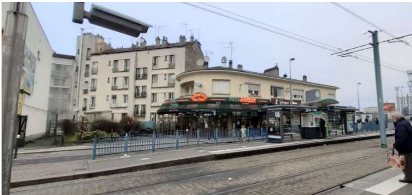
207. Photographie de la Rotonde (Source : Artelia-Richez, 2022)
