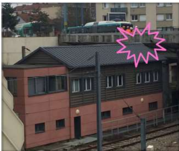
Poste de signalisation K
