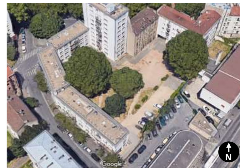
40. Placette et alignement d'arbres de la rue de la Gare – Cœur d'îlot de la Sablière (Artelia-Richez, 2022)
