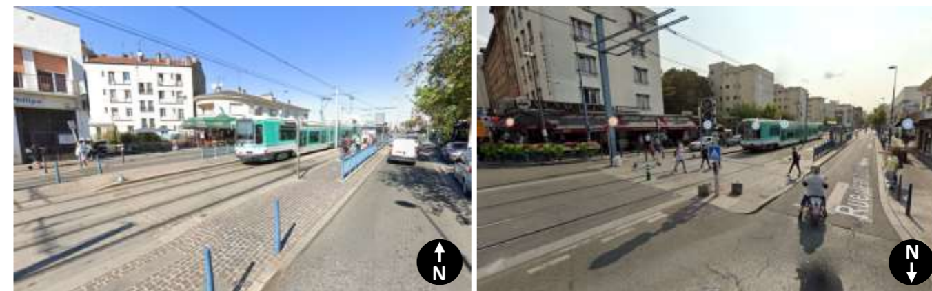
63. Station actuelle du T1 avant les travaux du prolongement (Gmaps, 2020)
