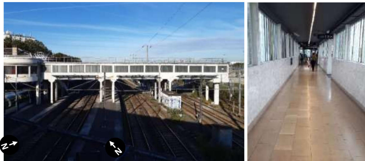
149. Vue depuis le pont Gallieni sur la passerelle et les extrémités Est des quais (Artelia-Richez, 2022)
