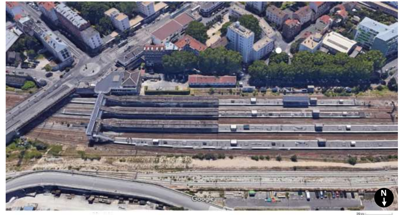
3. Vue aérienne 3D actuelle de la gare de Noisy-le-Sec depuis le nord (Source : Gmaps, 2022)
