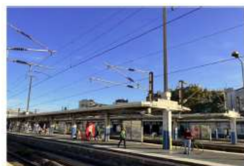
Abri support de poteaux caténares
