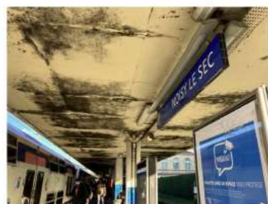
Sous-face des abris
