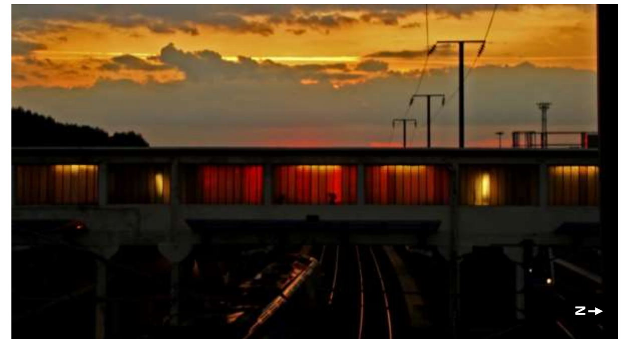
25. Passerelle d'accès aux quais historique (Source : Artelia-Richez, 2021)
