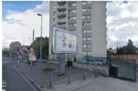
SITUATION EXISTANTE – IMMEUBLE EN R+11
