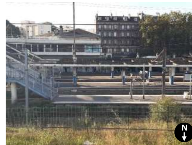
10. Vue sur le bâtiment voyageur (Artelia-Richez, 2021)
