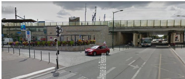
Figure 150 : Ouvrage SNCF à Chelles Source : Egis, 2019
