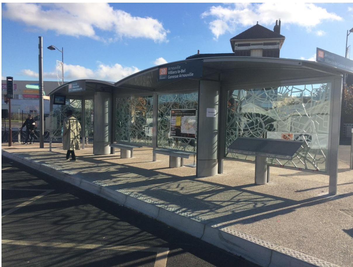
Exemple d'une station sur le tracé du Bus à Haut Niveau de Service Ligne 20 Villiers-le-Bel/Gonesse/Arnouville – Parc des Expositions de Villepinte
