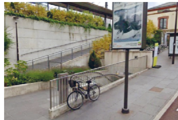
Émergence de la station Viroflay-Rive Droite du tram T6
