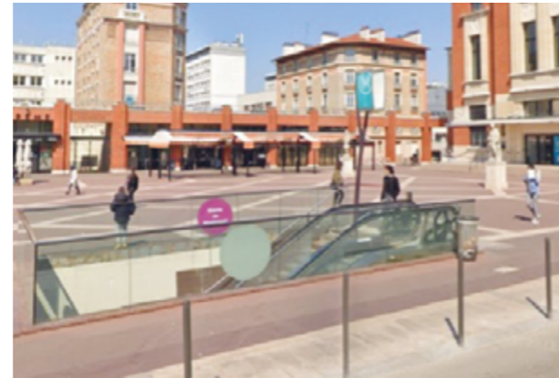
Émergence de la station Mairie de Montrouge du M4
