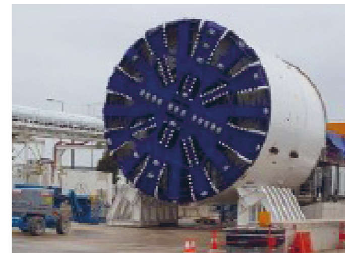
Exemple d'installations de chantier pour l'ouvrage de démarrage
