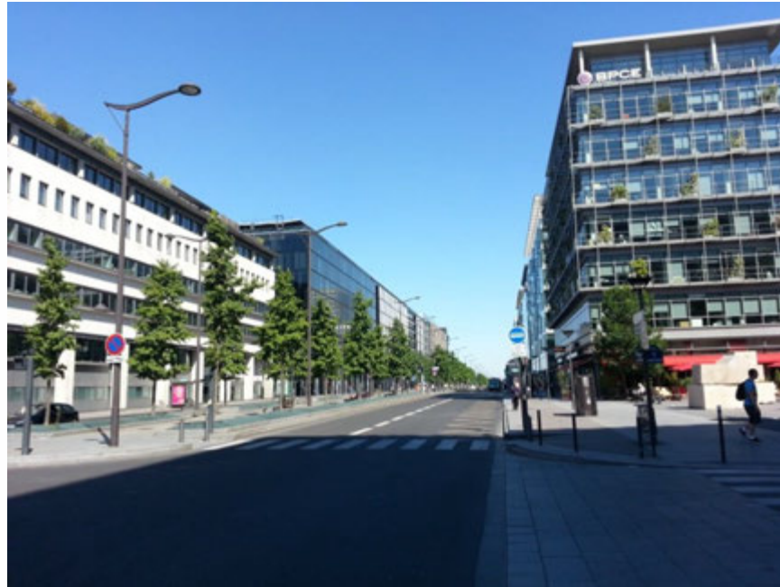
Figure 208 : Avenue de France Source : SNC-Lavalin, Juin 2014
