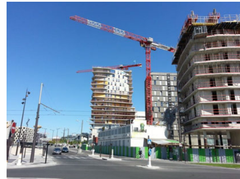
Figure 210 : Immeuble "Homes" (second plan au centre) Source :
