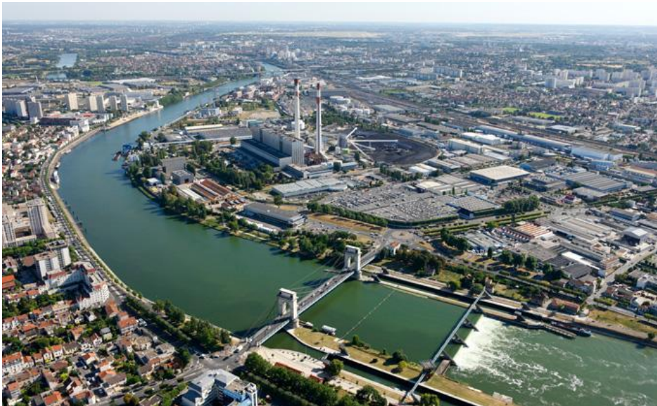
Figure 107 : Pont et écluse du Port à l'anglais - Alfortville/Vitry-sur-Seine Source : EPA ORSA / Philippe Guignard
