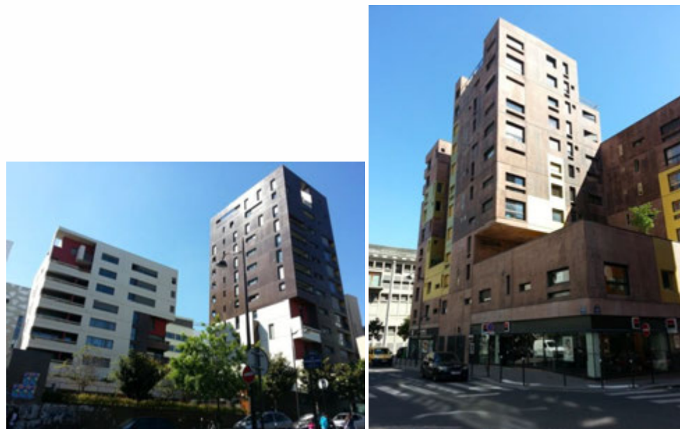
Figure 205 : Immeubles à Paris XIII Source : SNC-Lavalin, Juin 2014
