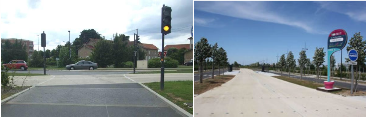
Figure 85 : Traitement des carrefours et des traversées piétonnes sur le T Zen 1 Source : Cahier de références des aménagements T Zen, STIF, Avril 2013
