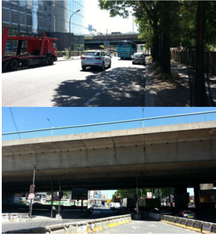
Figure 214 : Ouvrage d'art support du boulevard périphérique Source : SNC-Lavalin, Juin 2014
