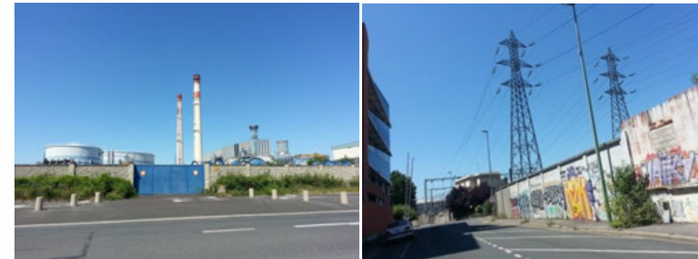
Figure 224 : Cheminée de la centrale EDF – Pylônes de lignes haute tension Source : SNC-Lavalin, Juin 2014
