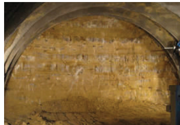
54 - Front de taille d'un tunnel en méthode séquentielle
