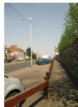
53 - Mur du Parc C. Flammarion
