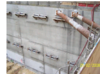
53 – Exemple de travaux d'ouvrage en parois berlinoises avec butons inclinés (Ouvrages Parc de la Mairie – Piver)
