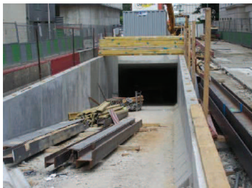
50 – Trémie d'accès en souterrain - cadre ouvert en U préfabriqué
