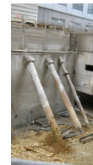
53 – Exemple de travaux d'ouvrage en parois berlinoises avec butons inclinés (Ouvrages Parc de la Mairie – Piver)
