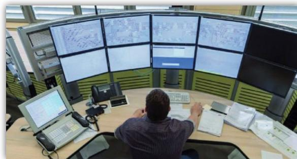
**Le poste de commandement à distance** assure quant à lui la gestion et la régulation du trafic, et vient en appui des conducteurs dans la gestion des incidents. Il assure également la sécurité et l'information des voyageurs.
