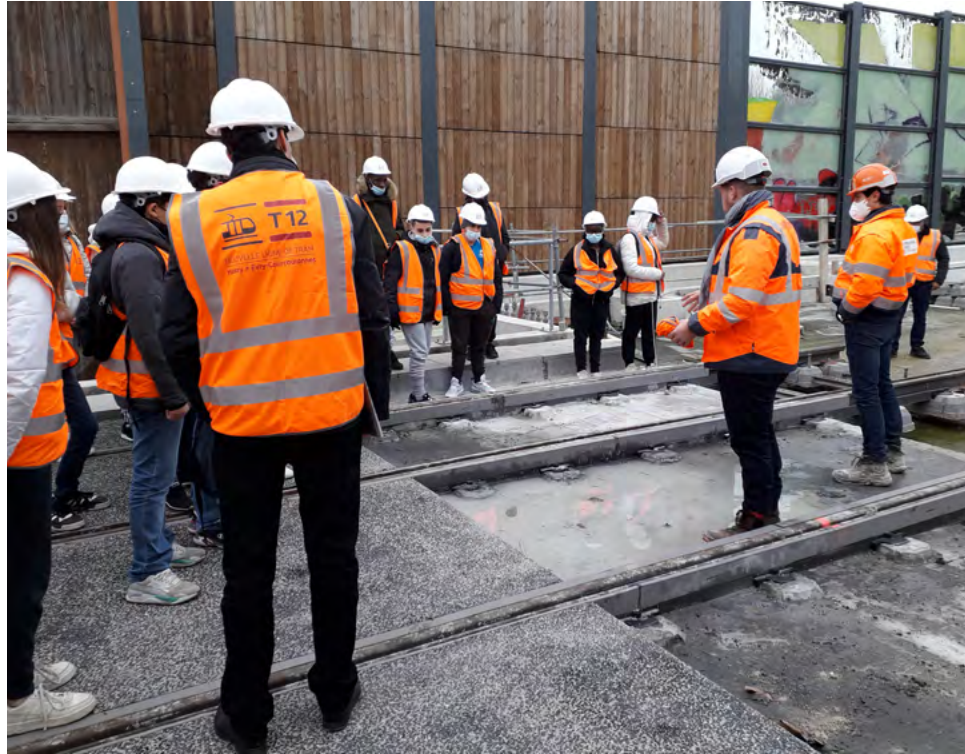
Visite et présentation des métiers qui interviennent pour la construction de la station aérienne Parc du Château, avec les élèves du collège Charles Peguy à Morsang-sur-Orge.
