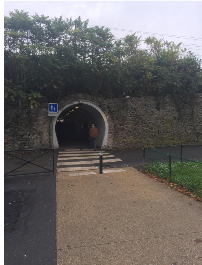
L'entrée Sud du souterrain ville-ville
