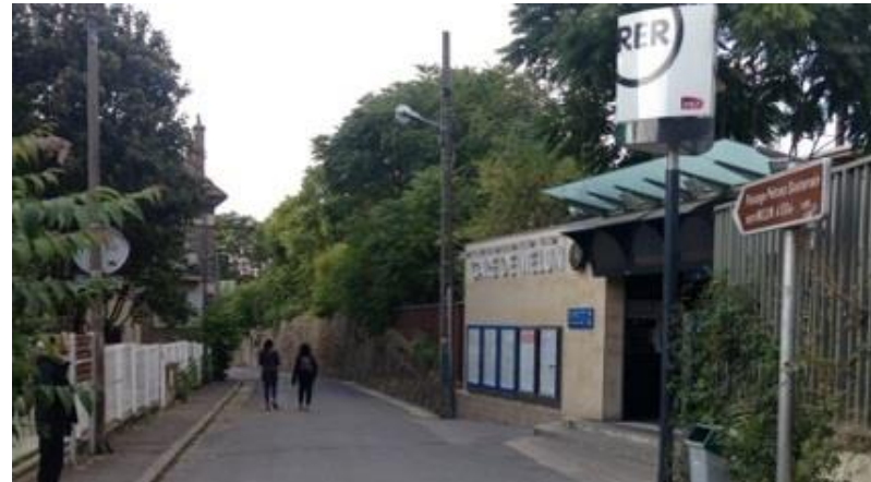
Accès secondaire au sud de la gare
