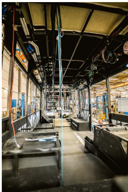
2 - Installation des câbles
