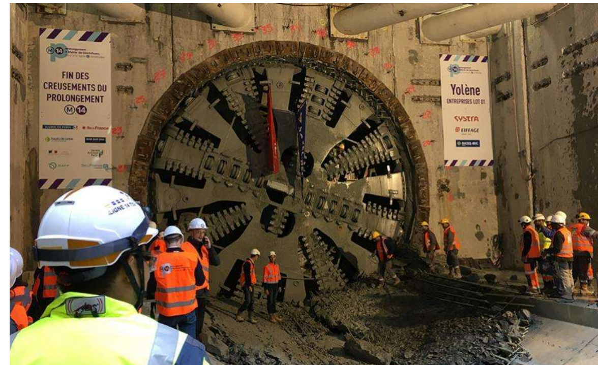
Figure 73 – Fin des creusements du second tunnelier Yolène entre Pont Cardinet et Clichy Saint-Ouen (Source : Eiffage)
