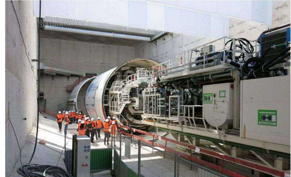
Figure 72 – Inauguration du tunnelier Magaly, qui a creusé la première partie du prolongement nord de la Ligne 14 entre Saint-Lazare et Mairie de Saint-Ouen (Source : Le Parisien)
