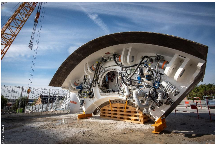
Assemblage du tunnelier à la gare de Bry - Villiers - Champigny (94)
