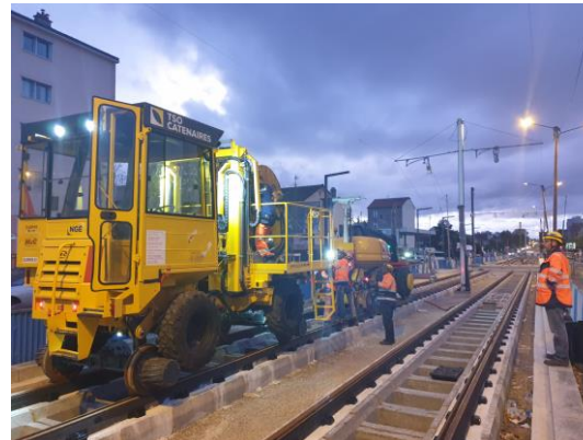
Mise en place des lignes aériennes de contact (LAC)
