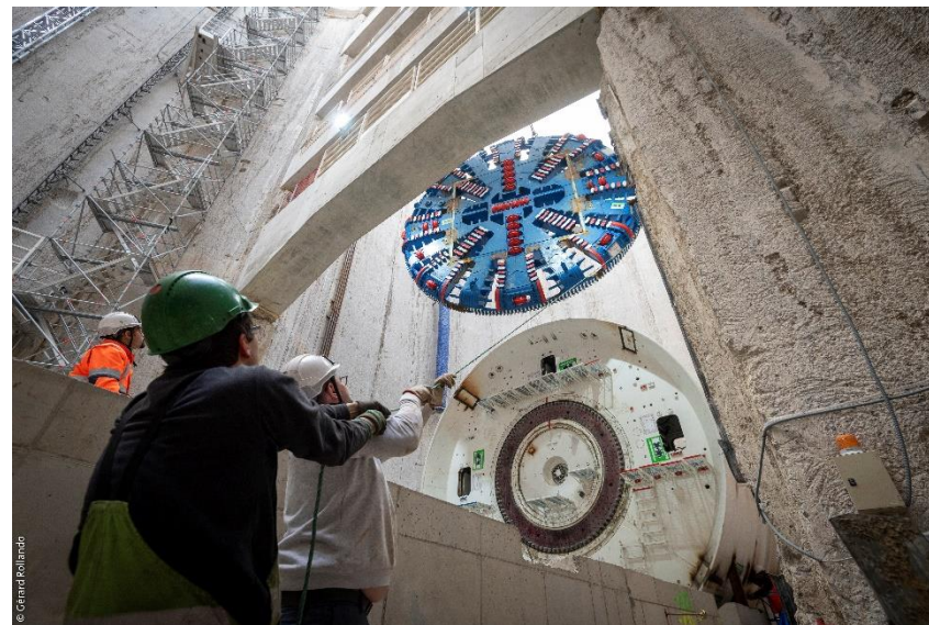
Descente des roues de coupe à la gare d'Arcueil-Cachan (94) et au puits « Robespierre » à Bagneux (92)
