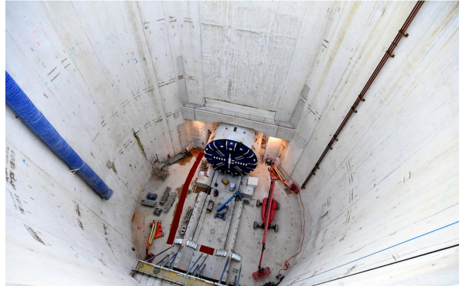
Puits « Maréchal Leclerc » à Massy (91)
