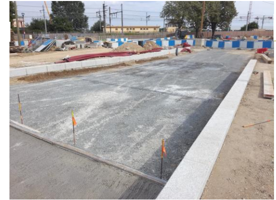
Pose des voies – Vue d'ensemble
