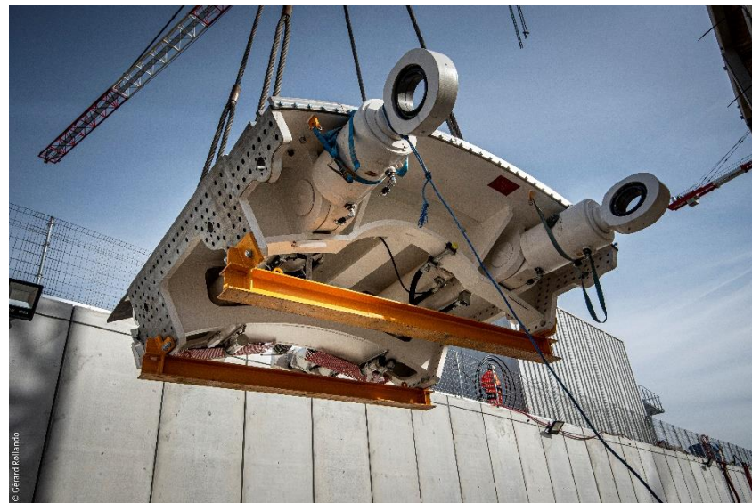
Assemblage du tunnelier à la gare de Bry - Villiers - Champigny (94)
