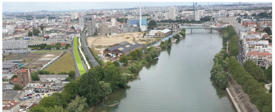
2. À la ZAC Ivry Confluences à Ivry-sur-Seine, une partie de l'avenue de l'Industrie a été ouverte à la circulation par la SADEV 94.
