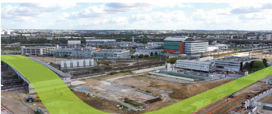
3. Les travaux du pont paysager des Ardoines progressent à Vitry-sur-Seine, sous la maîtrise d'ouvrage de Grand Paris Aménagement / EPA Orsa.
