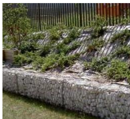
Muret en gabion
