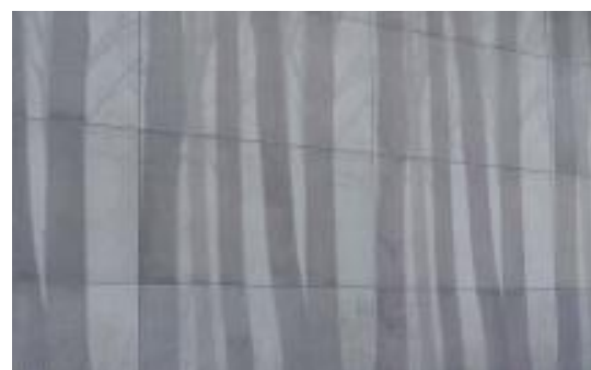
Mur en béton photogravé
