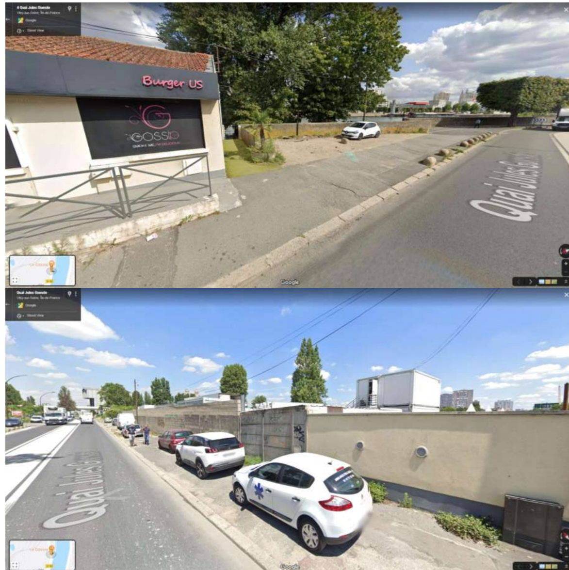
Fig. 46. Prolongement de la protection anti-crue, par des bâtiments et des murs pleins (Source : Google Maps, Street View)
