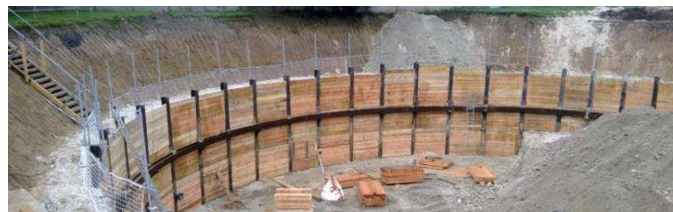
Figure 194 : Parois berlinoises (TOUT POUR LE FORAGE, 2020)
