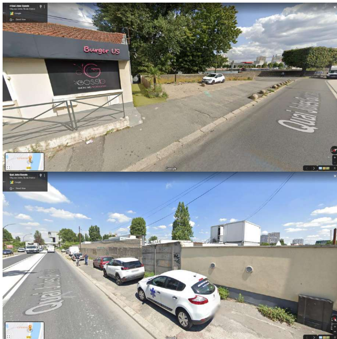
Figure 183 : Prolongement de la protection anti-crue, par des bâtiments et des murs pleins (Source : Google Maps, Street View)
