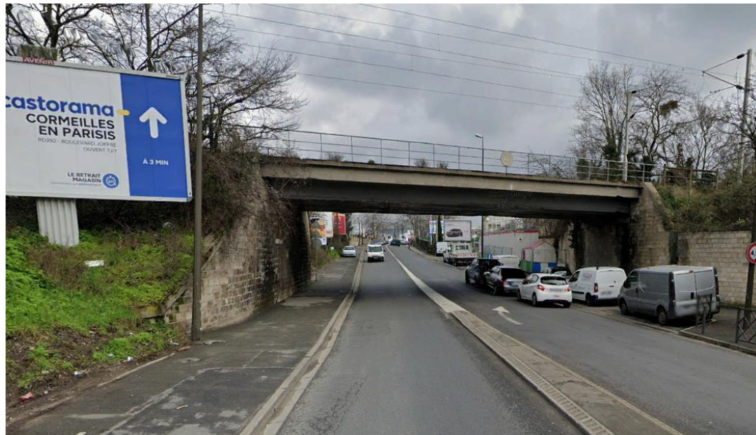
Figure 64 : Profil actuel de l'ouvrage SNCF situé sur la RD392
