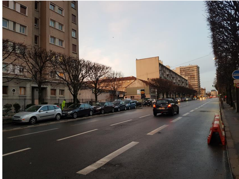
Figure 23 : Profil actuel sur le boulevard Léon Feix entre les rues Michelet et Belin
