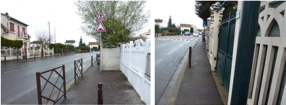
**Figure 53 : Largeur de trottoirs non conforme à la réglementation accessibilité avenue Clémenceau à Sartrouville**
