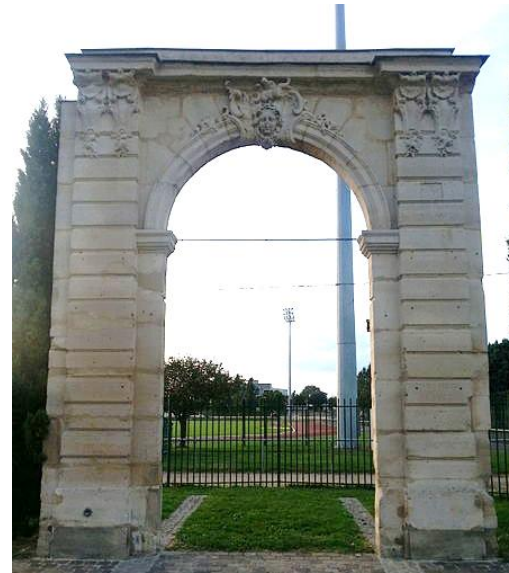
Figure 82 : Porte du Château du Marais (source : monumentum.fr)
