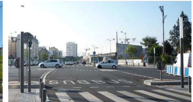
Figure 23 : Site propre existant sur RD392 entre le Pont de Bezons et la rue Edouard Vaillant
