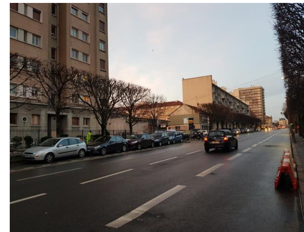
Figure 11 : Profil actuel sur le boulevard Léon Feix entre les rues Michelet et Belin
