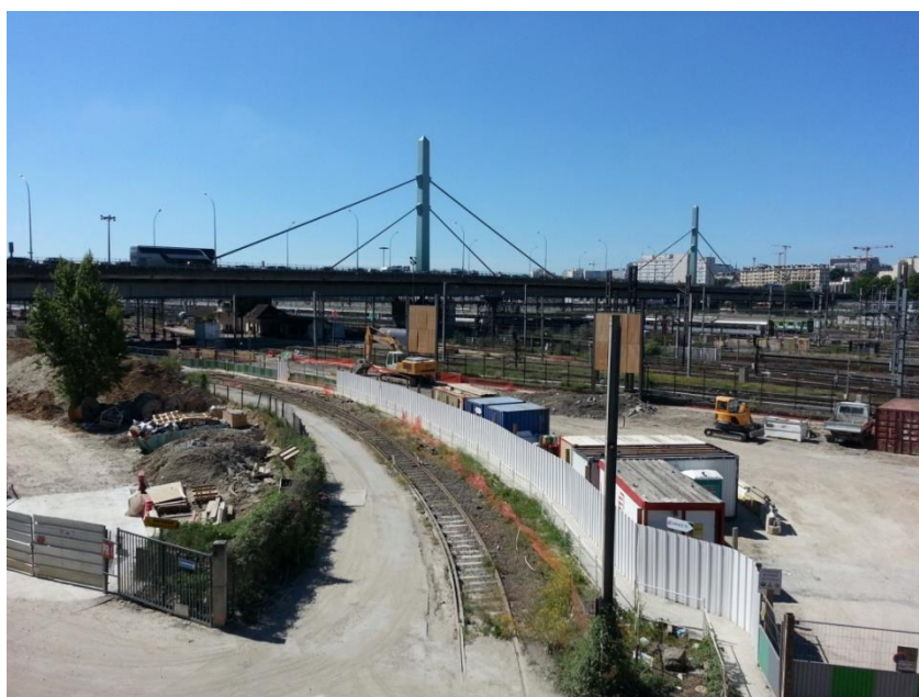
Figure 242 : Boulevard des Maréchaux (arrière plan) et voies ferrée depuis l'avenue de France Source : SNC-Lavalin, Juin 2014
