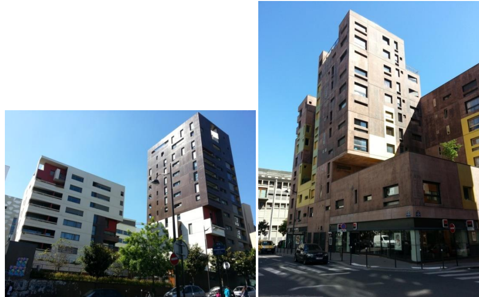
Figure 235 : Immeubles à Paris XIII Source : SNC-Lavalin, Juin 2014
