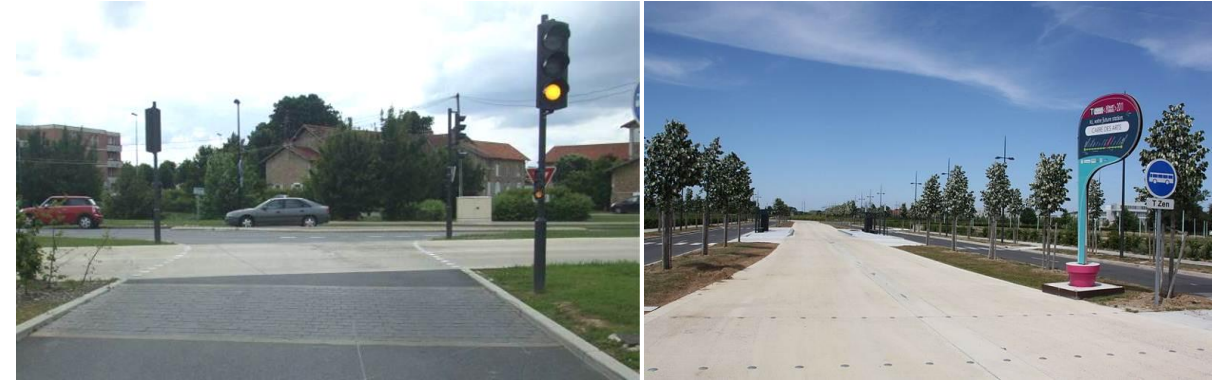
Figure 74 : Traitement des carrefours et des traversées piétonnes sur le T Zen 1 Source : Cahier de références des aménagements T Zen, STIF, Avril 2013
