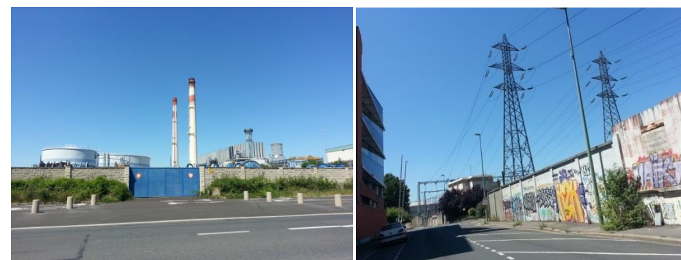
Figure 254 : Cheminée de la centrale EDF – Pylônes de lignes haute tension Source : SNC-Lavalin, Juin 2014
