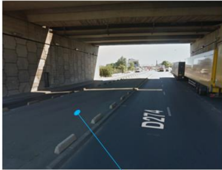
lot existant assurant le dénivelé entre voies
