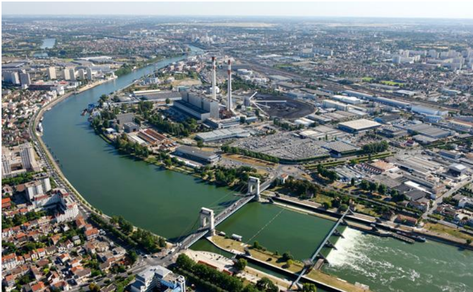
Figure 98 : Pont et écluse du Port à l'anglais - Alfortville/Vitry-sur-Seine Source : EPA ORSA / Philippe Guignard
