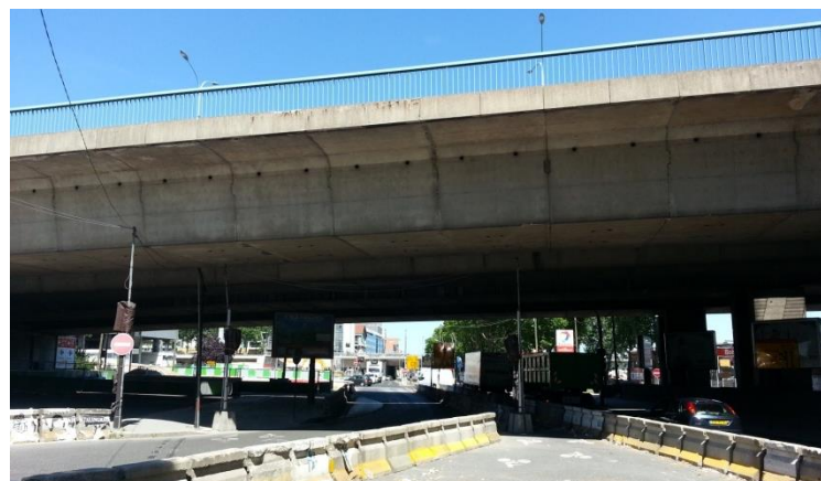
Figure 244 : Ouvrage d'art support du boulevard périphérique Source : SNC-Lavalin, Juin 2014
