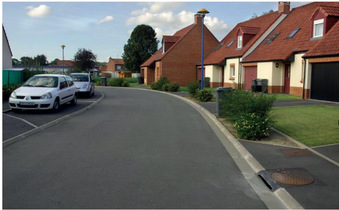
Figure 132 : Exemple de chaussée structure réservoir étanche avec injection localisée (Eurométropole de Lille)
