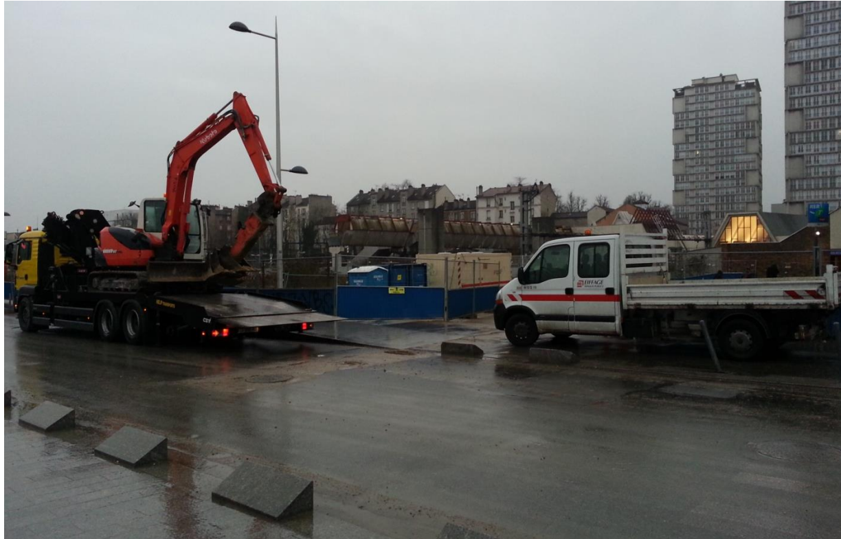
Figure 23 : Travaux de réseaux au droit de la gare RER de Choisy-le-Roi Source : SNC-Lavalin, Février 2015
