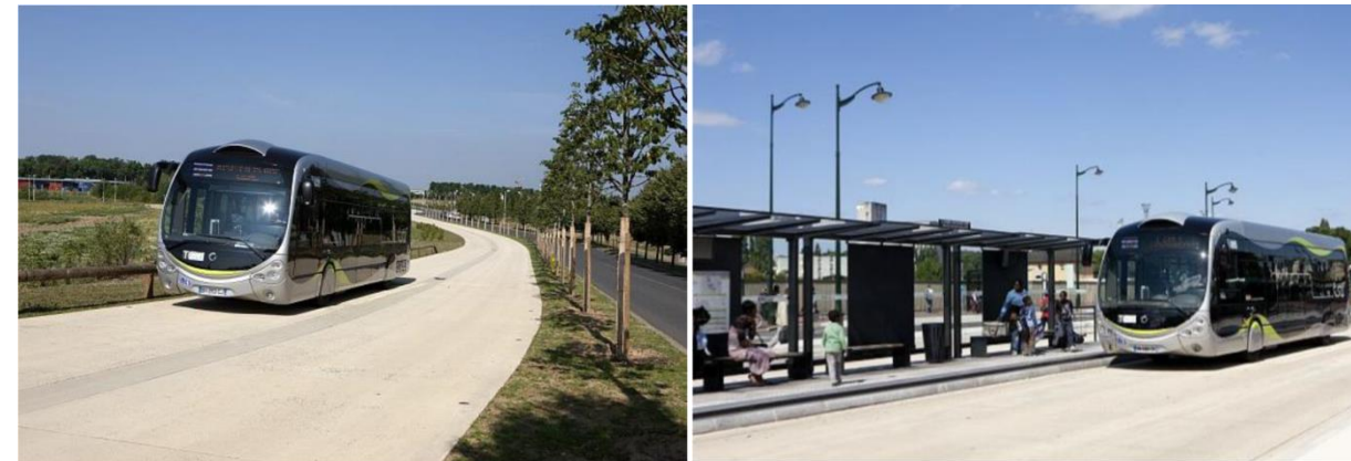
Figure 93 : Plateforme et station du T Zen Source : Cahier de références des aménagements T Zen, Ile-de-France Mobilités, Avril 2013
