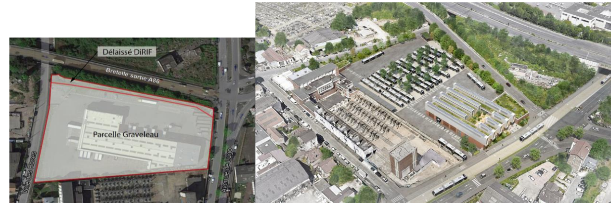
Figure 129 : Parcelle actuelle / AVP du Site de Maintenance et de Remisage de Choisy-le-Roi (APS, Ile-de-France Mobilités, Richez&Associés, Egis, 2020)
