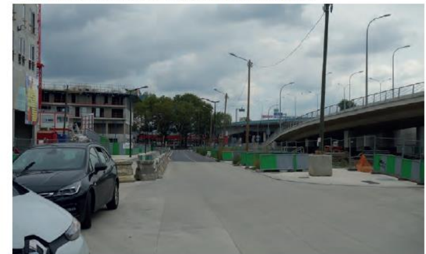
> Rue Berlier, la plateforme Tzen réalisée en avance de phase
