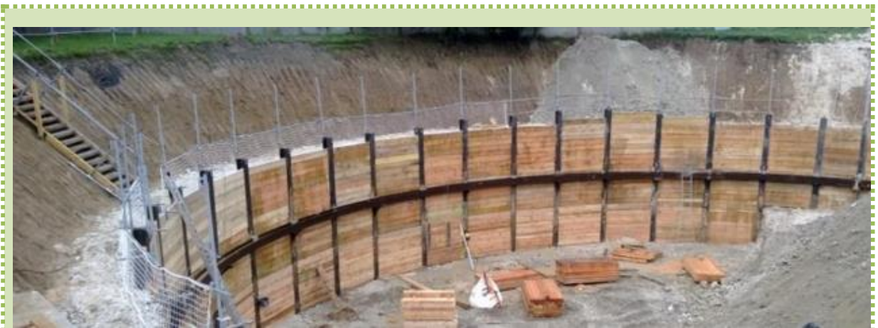
Figure 6 : Parois berlinoises (TOUT POUR LE FORAGE, 2020)
