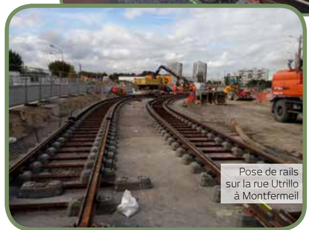
Pose de rails entre la rue Utrillo et l'allée Romain Rolland entre Clichy-sous-Bois et Montfermeil
