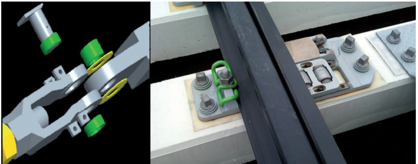
Figure 27 - Roulement de tringle et rouleaux d'aiguille sans lubrification
