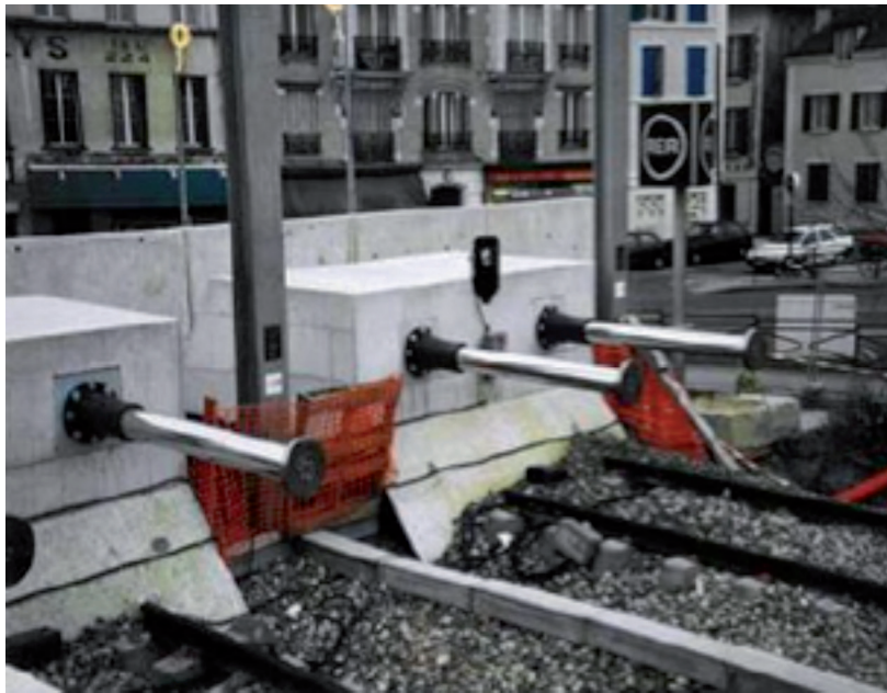
Figure 28 - Figure Heurtoir fixe à vérins – Gare RER de Poissy
