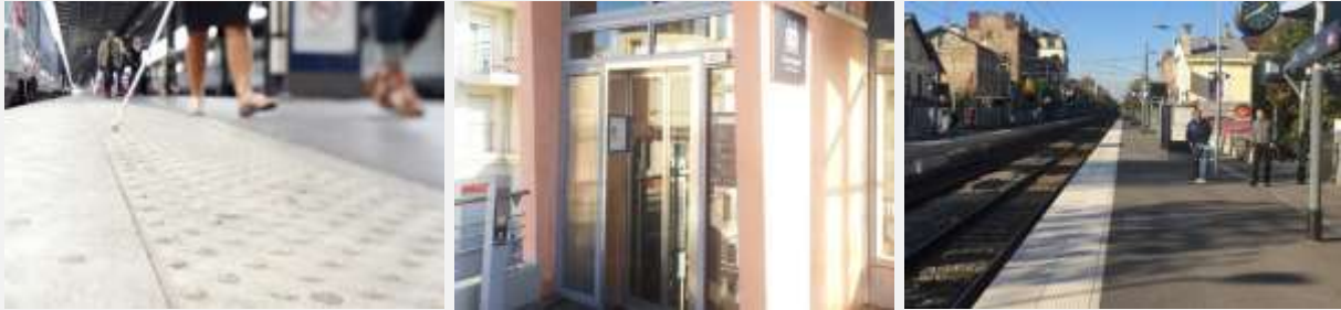
Figure 23. Mise en accessibilité de la gare de la Barre Ormesson
