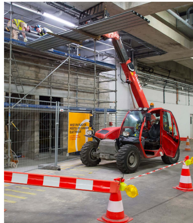
Installation de la distribution électrique au centre bus de Lagny (électrique)
