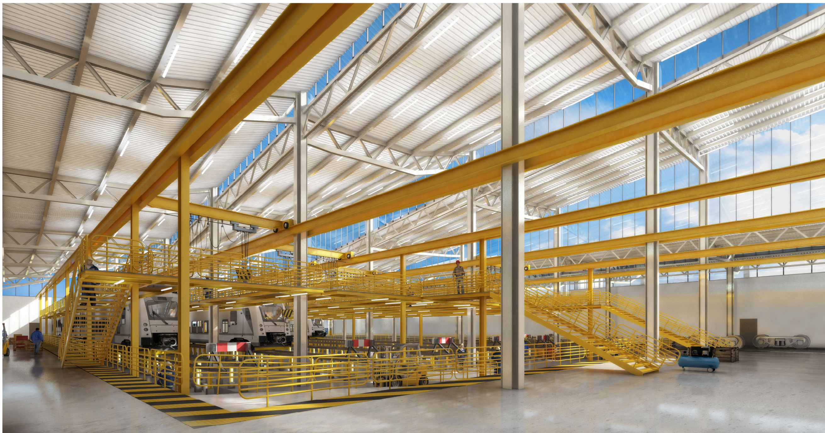
Figure 43 : SMR hall de maintenance courante : lisibilité des accès aux passerelles et lumière naturelle
