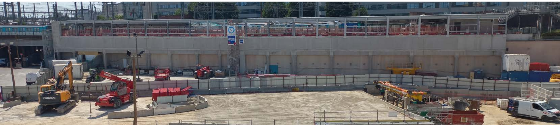
Chantier à la station Châtillon-Montrouge
