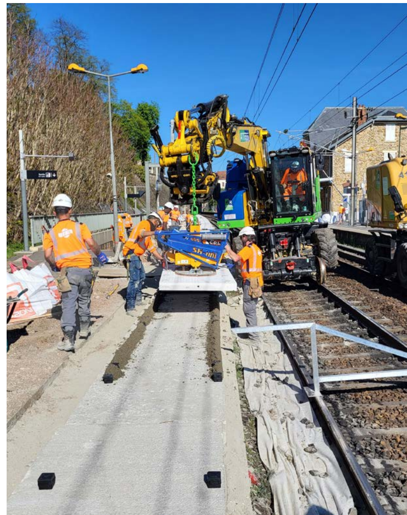
Travaux rehaussement de quai - Gare Ferté Sous Jouarre
