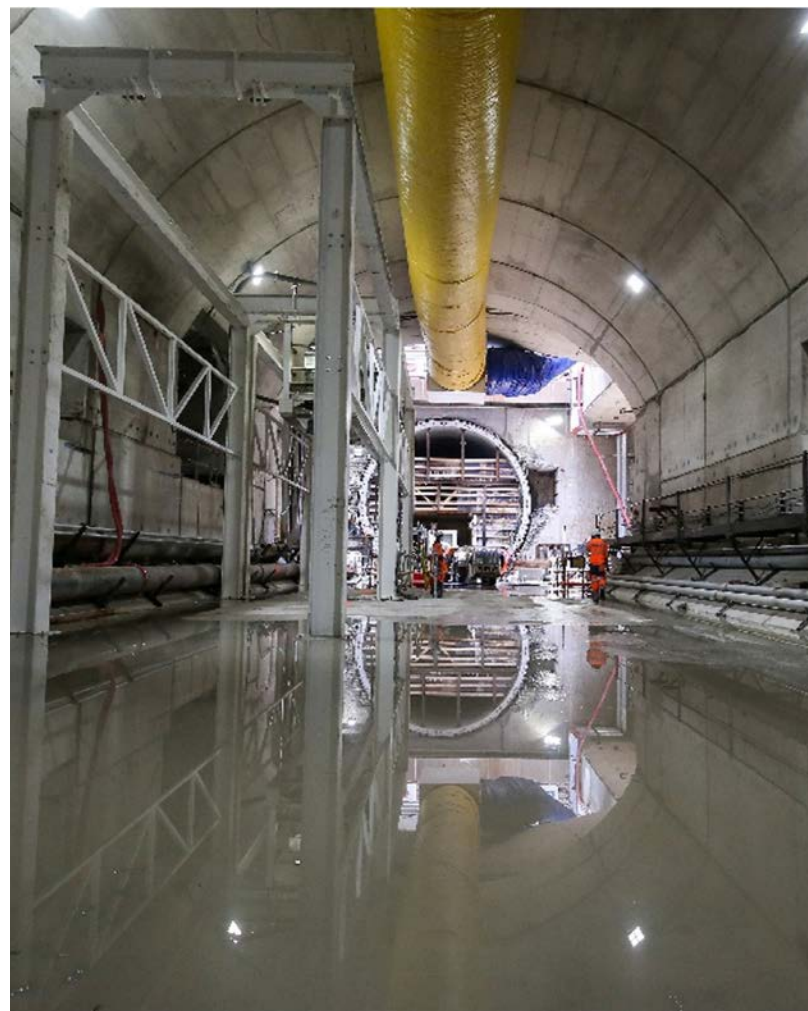
Terrassement de la gare de la Porte Maillot - Direction du Projet Eole - SNCF Réseau
